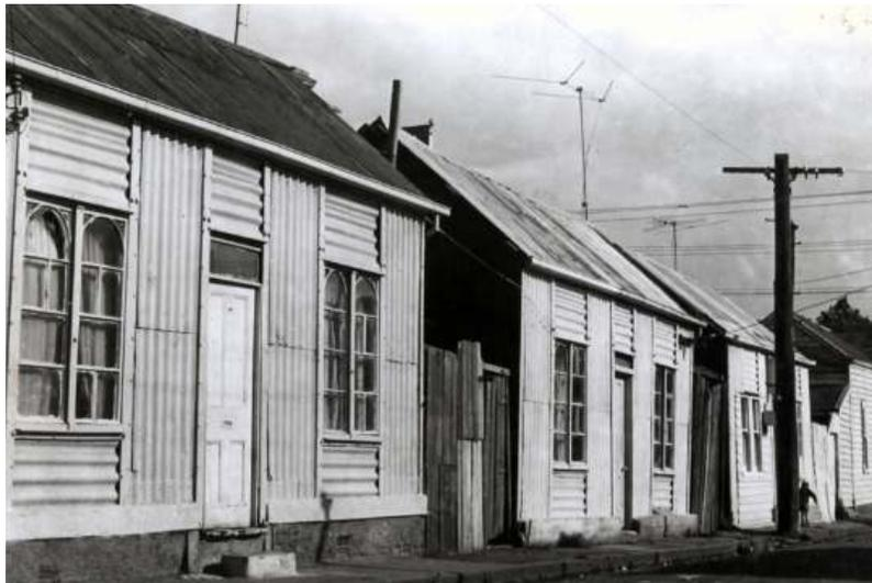
37. Casas prefabricadas con planchas onduladas, Australia.
